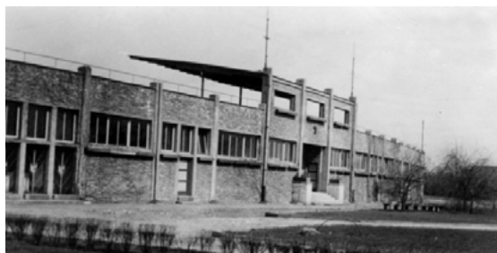
Fig. 13. Cracow, al. 3-go maja, city sports stadium, source: www.szlakmodernizmu.pl , 23.05.2020.
