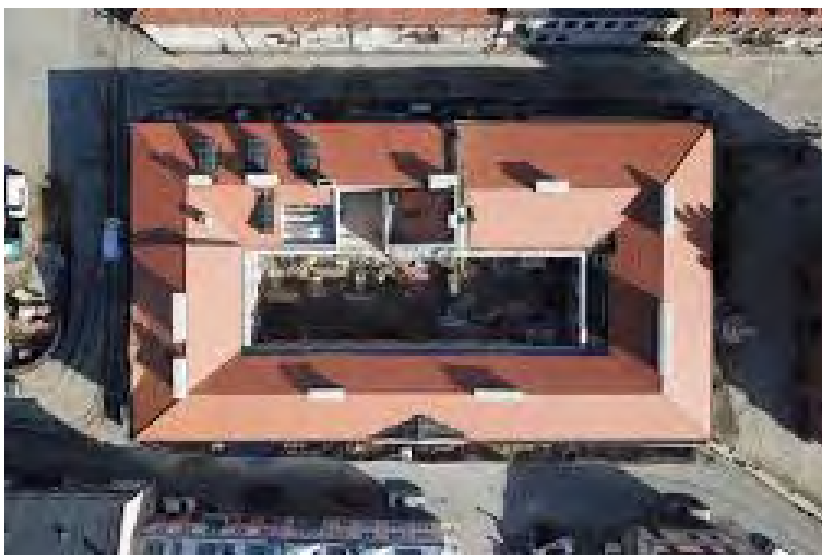
Ryc. 1. Regularny kształt Domu Deskurów z wewnętrznym obudowanym patio w czasie prac remontowych – widok z góry [22]
