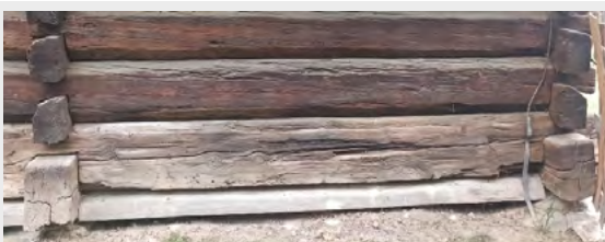
Ryc. 25. Chałupa z Bukowej, na przestrzeni lat brak istotnych zmian w stanie technicznym podwaliny i belek sumikowych ścian
