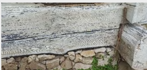
Ryc. 7. Chałupa z Brzezina, uzupełnienie podmurówki i naprawa izolacji poziomej, powłoka malarska niejednolita, spękana i odspojona
