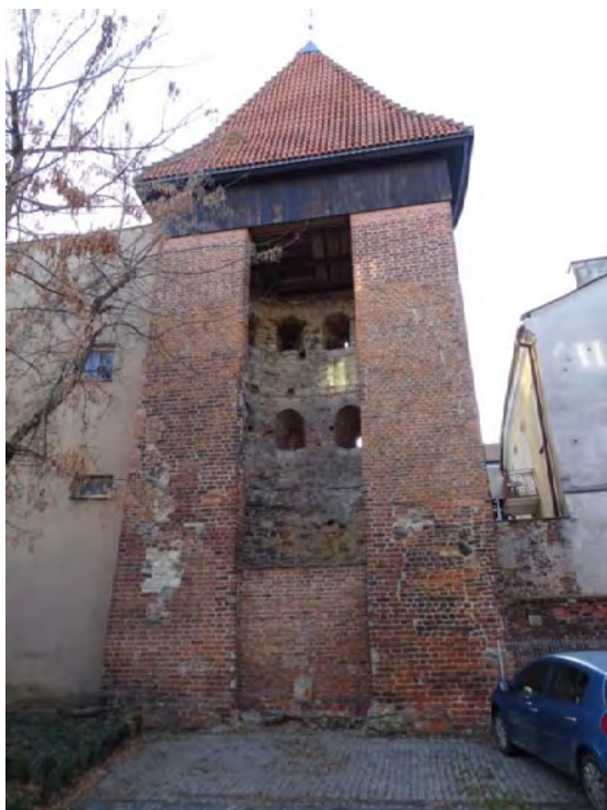
Ryc. 1. Elewacja północna baszty
