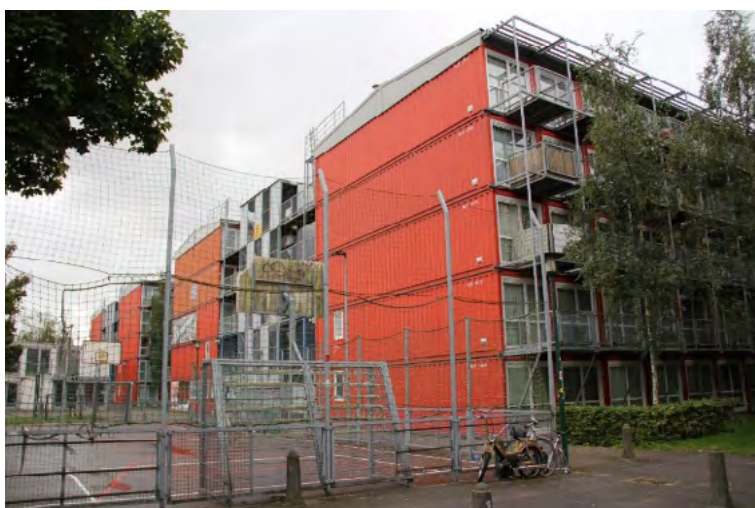
Ryc. 2. Miasteczko studenckie w Amsterdamie skonstruowane z kontenerów mieszkalnych – widok. Źródło: fotografia autora
