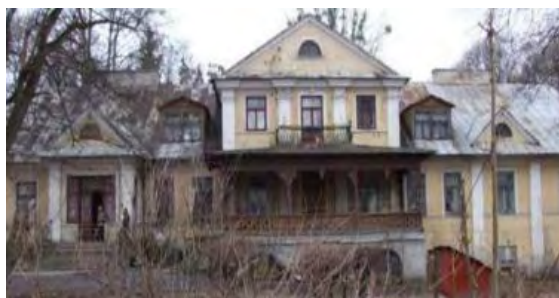
Fot. 6. Dwór w Siedliskach, Widok elewacji północno-wschodniej [3]. Stan na 2010 r.
