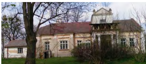
Fot. 19. Dwór w Stawie Noakowskim, widok elewacji południowo-zachodniej. Stan na 2015 r.
