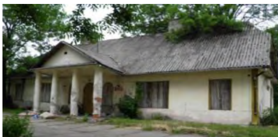
Fot. 13. Dwór w Krasnymstawie, widok elewacji południowej [1]. Stan na 2014 r.
