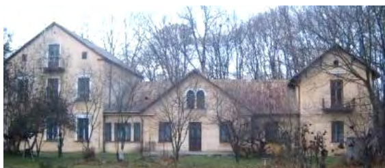
Fot. 15. Dwór w Rybczewicach, widok elewacji południowej. Stan na 11.2006
