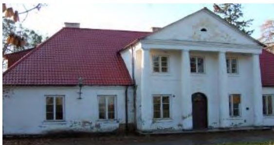
Fot. 9. Dwór w Zaburzu, widok elewacji północnej. Stan na 2007 r.
