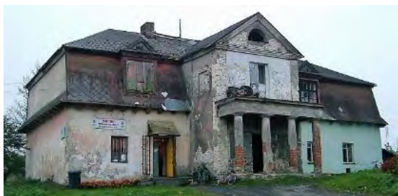
Fot. 17. Dwór w Siedliszczkach, widok elewacji zachodniej. Stan na 2007 r.
