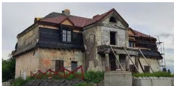
Fot. 18. Dwór w Siedliszczkach, w trakcie prac remontowych, widok elewacji zachodniej. zdjęcie z FB. Stan na 07.2021
