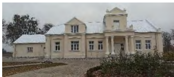
Fot. 20. Dwór w Stawie Noakowskim, widok elewacji południowo-zachodniej. Stan na 11.2021
