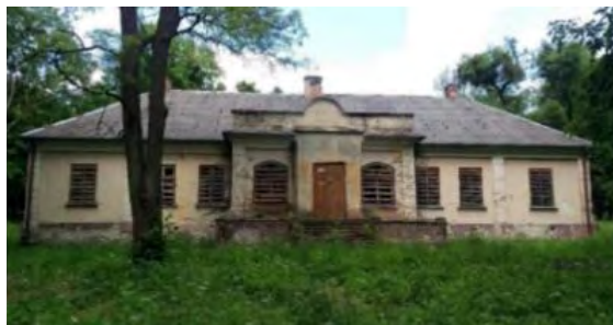
Fot. 2. Dwór w Łopienniku Dolnym, widok elewacji południowej [4]. Stan na 2017 r.
