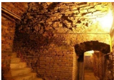
Ryc. 13. Piwnica, część D, widok na ścianę wschodnią. Fot. K. Janus Fig. 13. Basement, part D, view on eastern wall. Photo K. Janus
