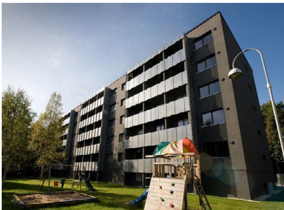
Ryc. 5. Modernizacja budynku z wielkiej płyty, Haapsalu, Estonia. Źródło ilustracji: http://www.professionals.ee Fig. 5. Modernisation of the “great panel” building in Haapsalu, Estonia. Source: http://www.professionals.ee
