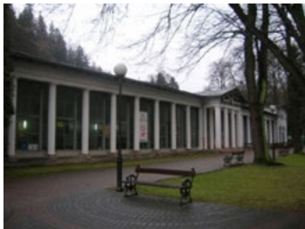
Ryc. 3. Hala spacerowa w Dusznikach-Zdroju, (fot. M. Piróg)
