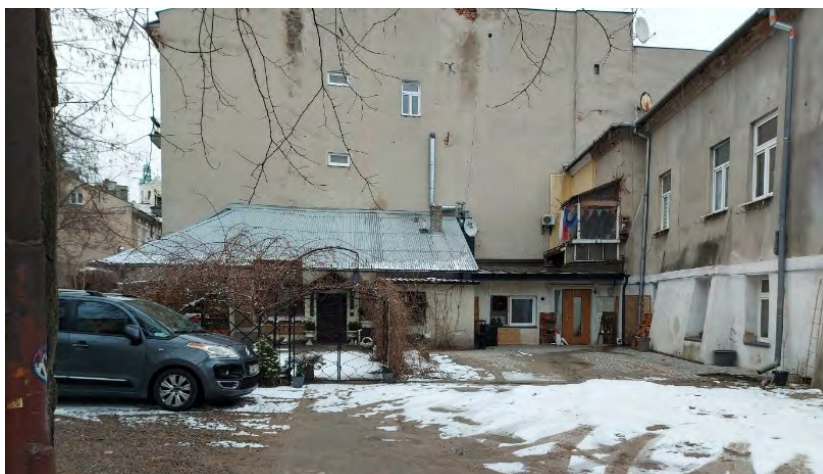
Ryc. 5. Obiekt zakwalifikowany do rozbioru oraz przykład przestrzeni wymagającej uzupełnienia zabudową plombową. Źródło: Autorzy
