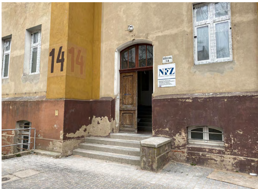
Ryc. 16. Widok na Oddział nr 14 podczas remontu. Źródło: Daria Smyl
