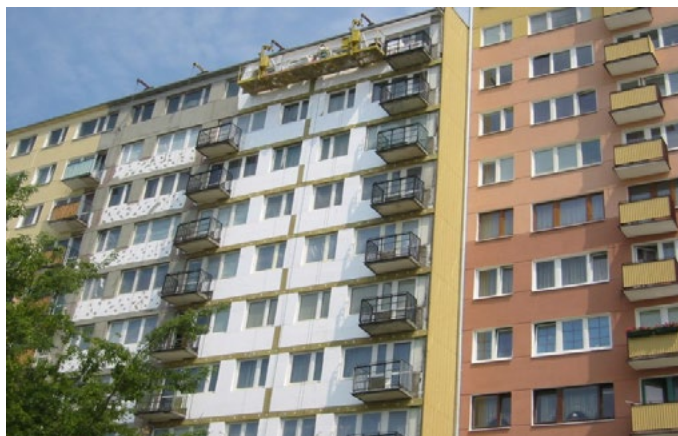
Ryc. 2. System wielkopłytkowy, ocieplenie wykonano bez oceny stanu technicznego wieszaków, budynek w I. etapie ocieplono – ściany szczytowe i filarki – metoda lekka-sucha, w II. etapie ocieplono: belko-ściany na fasadach i wymieniono ocieplenie na filarkach międzyokiennych – metoda BSO (styropian); zachowano detal podziału elewacji na filarki międzyokiennie i belko-ściany; stan w 2003 roku
