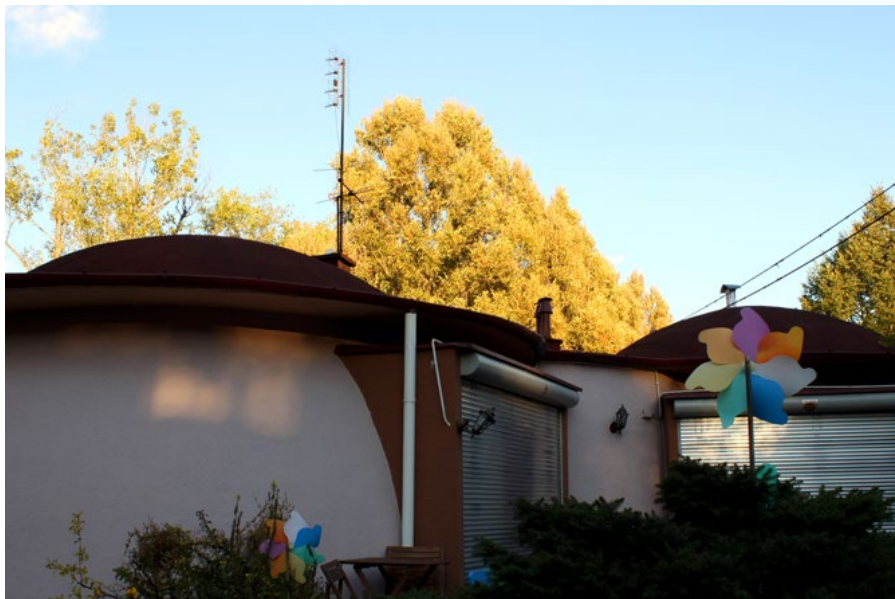
Ryc. 1. Domy Kopułowe przy ul. Ustrzyckiej w Warszawie, obecny stan (fot. Anna Łyszcz) Fig.1 The Dome Houses at Ustrzycka street in Warsaw, present condition (fot. Anna Łyszcz)
