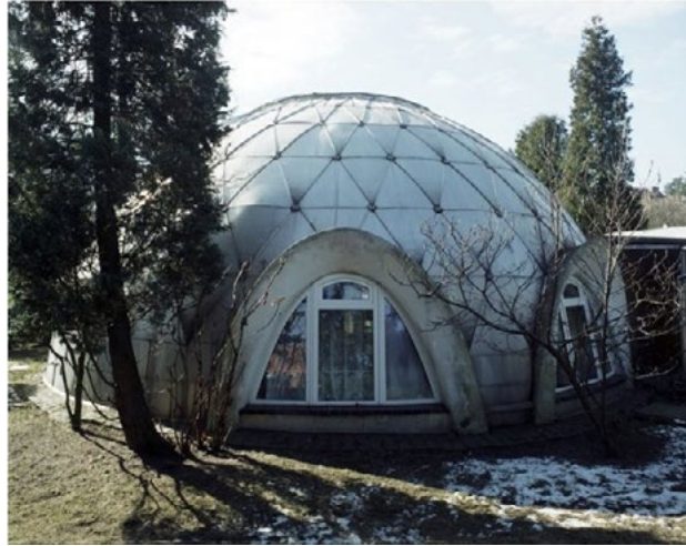
Ryc. 3. Dom Igloo architekta W. Lipińskiego przy ul. Moniuszki we Wrocławiu (fot. Filip Springer) Fig. 3. The Igloo House of an architekt W. Lipiński at Moniuszki street in Wrocław (fot. Filip Springer)
