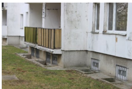
Ryc. 3. Harnasie 3. Fragment budynku prefabrykowanego z 1980 r. po ociepleniu w latach 90. i częściowej wymianie stolarki okiennej
