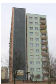
Ryc. 20. Króla Rogera 6. Budynek prefabrykowany z 1986 r. po ociepleniu w latach 90. i częściowej wymianie stolarki okiennej. Widok ogólny od strony północno-wschodniej Widok ogólny od strony południowej
