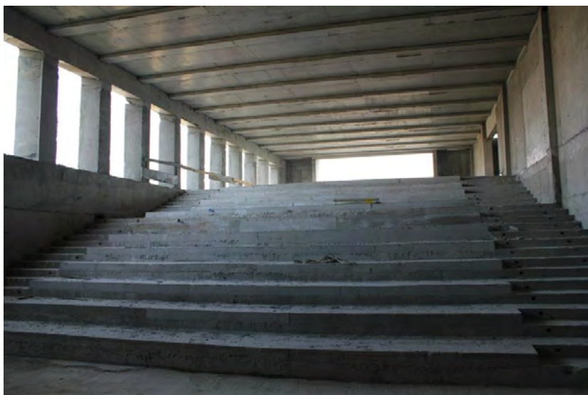
Ryc. 8. Zdjęcie z budowy budynku WICA, widok na aulę III od wejścia, rok 2012
