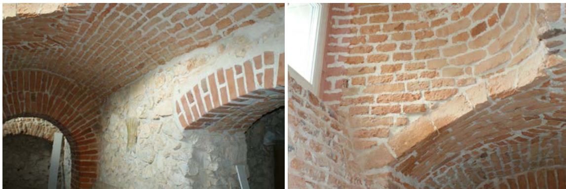
Ryc. 3. Pałac w Cianowicach, widok wnętrza piwnic, stan po modernizacji, 2014 (źródło: dokumentacja Właściciela obiektu, dostęp 2015).
