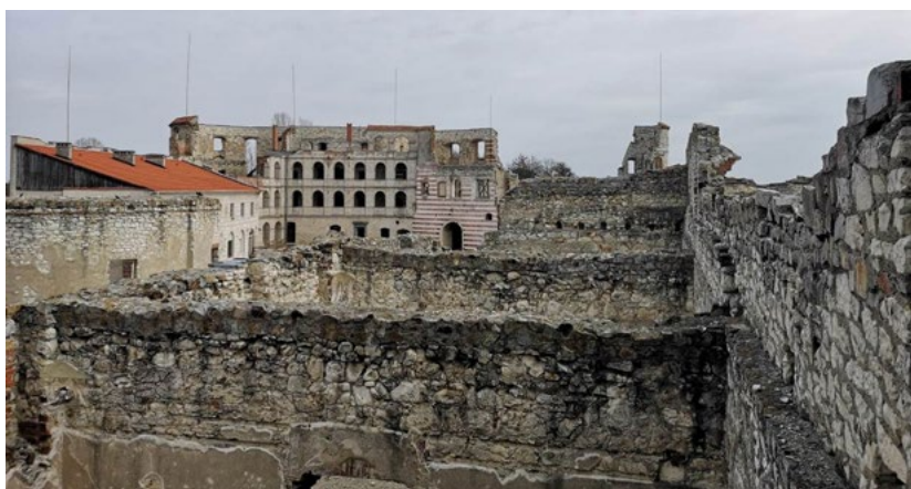
Ryc. 7. Widok na amfiladę południową oraz budynek bramny i skrzydło wschodnie. Autor: Katarzyna Drobek
