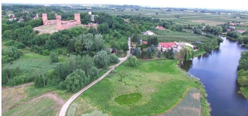
Ryc. 2. Ruiny zamku na tle Czerska i widok na jezioro Czerskie. Autor: Bartosz Szostak
