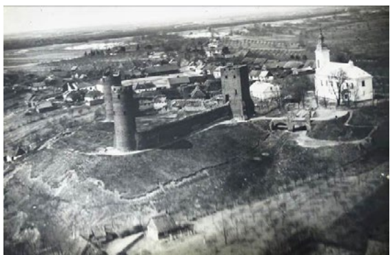
Ryc. 11. Zdjęcie lotnicze, widok od strony poł.-wsch., Autor: por. Wasilewski, Źródło: oprac. I. Galicka, fot. R. Kazimierski, red A. Grzybkowski, Dokumentacja architektoniczno-konserwatorska, Archiwum MWKZ
