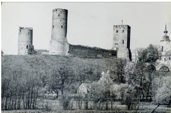
Ryc. 12. Widok od strony poł.-wsch., 1966 r., Autor: R. Kazimierski, Źródło: oprac. I. Galicka, fot. R. Kazimierski, red A. Grzybkowski, Dokumentacja architektoniczno-konserwatorska, Archiwum MWKZ
