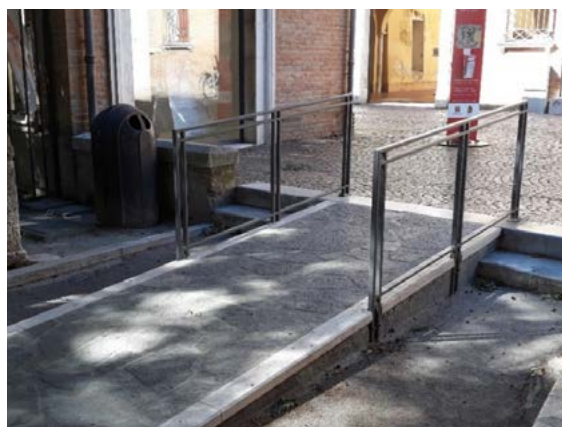
Fig. 2. Open door ramp, Ravenna; Photo: Katarzyna Kielin
