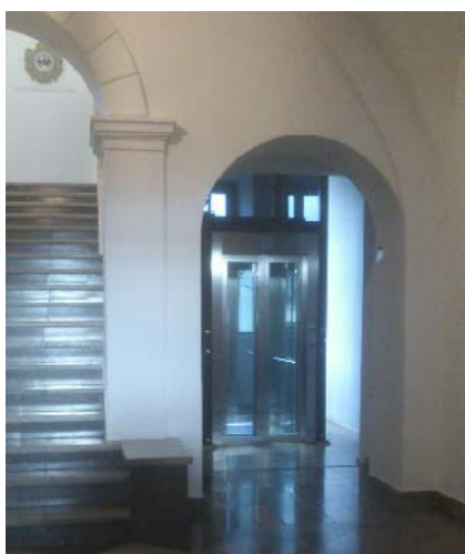
Fig. 5. The lift installed in the Zamość Town Hall, Zamość. Photo: Katarzyna Kielin
