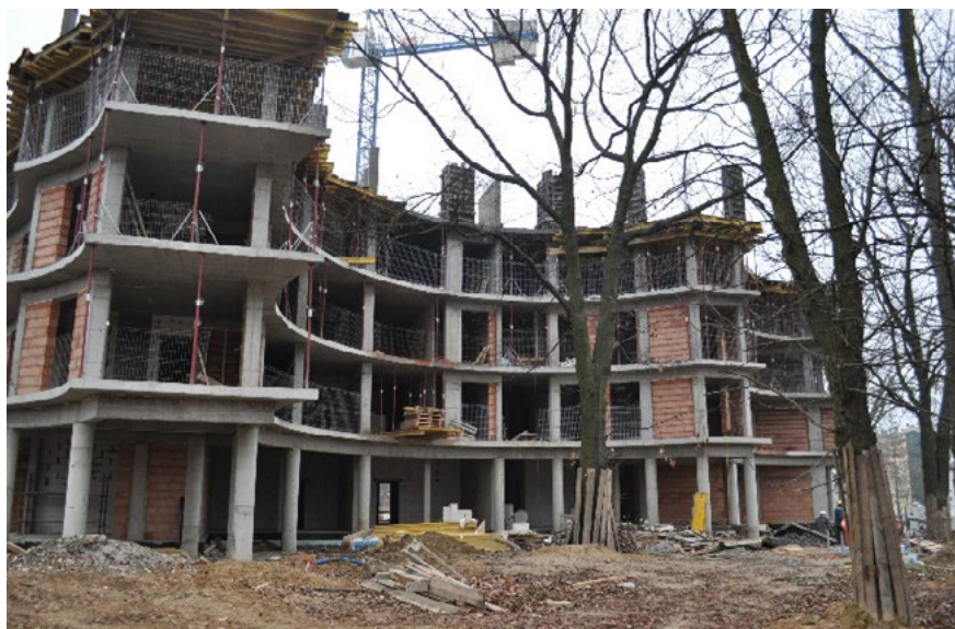
Ryc. 1. Zespół zabudowy mieszkaniowej „Kraśnicka Residence”: Budynek „B1” i „B2” w budowie. (fot. autor, grudzień 2020)
