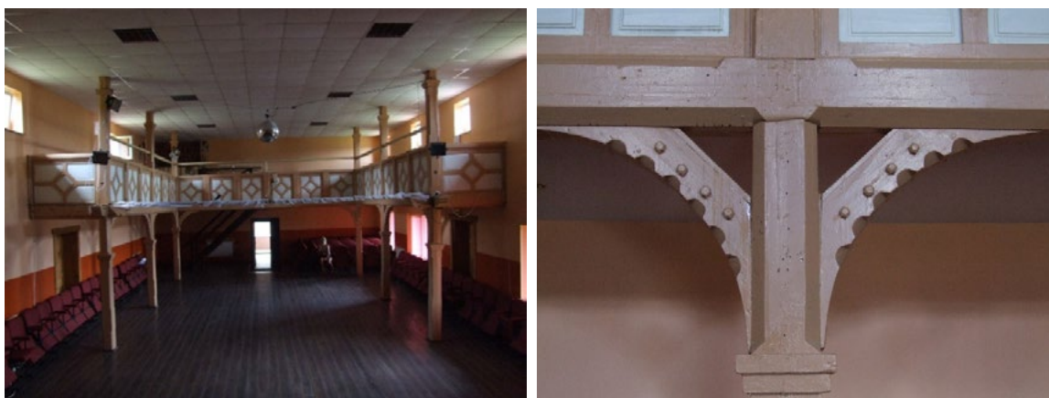
Ryc. 25. 26. Worochta. Dawny Dom Ludowy. Wnętrze sali widowiskowej oraz zastrzał podtrzymujący antresolę (Fot. autora, 2019)
