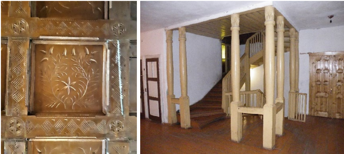
Ryc. 16. 17. Worochta. Dawny pensjonat „Liliana”. Fragment kasetonowego stropu jadalni oraz klatki schodowej na kondygnacji parteru (Fotografie autora, 2019 r.)
