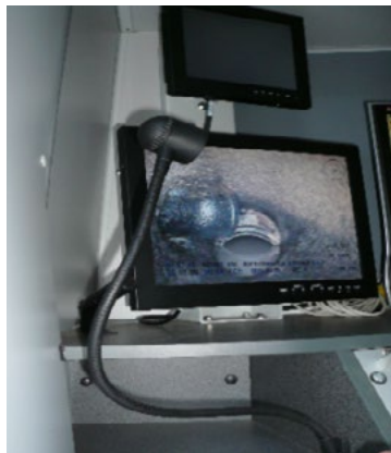
Ryc. 10. Kanalizacyjna studzienka rewizyjna, brak złożeń, podgląd kamerą wziernikową przez MPWiK Fig. 10. Sewer inspection chamber, no deposits observed, picture taken by means of an inspection camera by a municipal water company.
