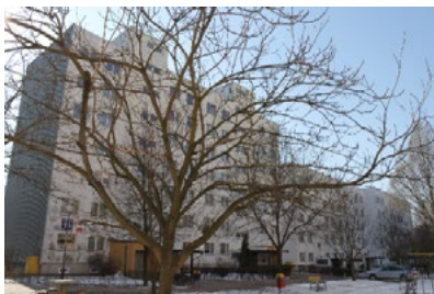
Ryc. 9. Harnasie 19. Budynek prefabrykowany z 1983 r. po ociepleniu w latach 90. i częściowej wymianie stolarki okiennej Fig. 9. Building at Harnasie 19, erected in 1983, – insulated in nineteen-nineties,, with windows partially replaced
