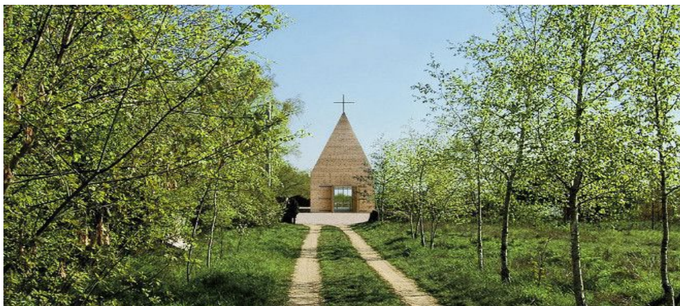
Ryc. 2. Votum Aleksa w Tarnowie, autorstwa pracowni projektowej „Beton”. Źródło: sztuka-architektury.pl Fig. 2. Alex's Votum chapel in Tarnów, Poland. Author: "Beton" design studio. Source: sztuka-architektury.pl
