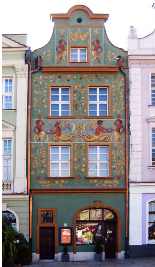
Ryc. 2. Kamienica na Starym Rynku 66 po wymianie rynien i konserwacji i restauracji polichromii w 2010 r.
