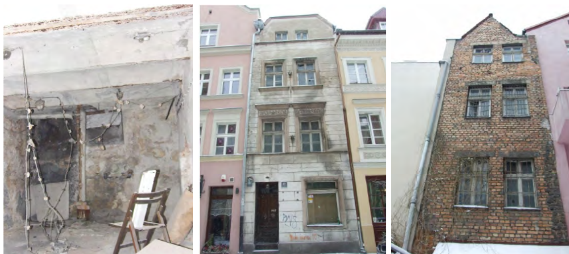
Ryc. 3. Po lewej: zdjęcie wnętrza kamienicy Wroniecka 23 – stan przed remontem; W środku: zdjęcie elewacji frontowej kamienicy Wroniecka 23 – stan przed remontem; Po prawej: zdjęcie elewacji tylnej kamienicy Wroniecka 23 – stan przed remontem
