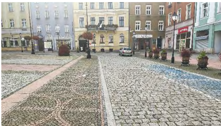
Ryc. 8. Nieodpowiednie wyróżnienie posadzki na granicy strefy pieszej i samochodowej, będącej utrudnieniem dla osób niewidomych i słabowidzących, fot. Katarzyna Szmygin, Wałbrzych 2021
