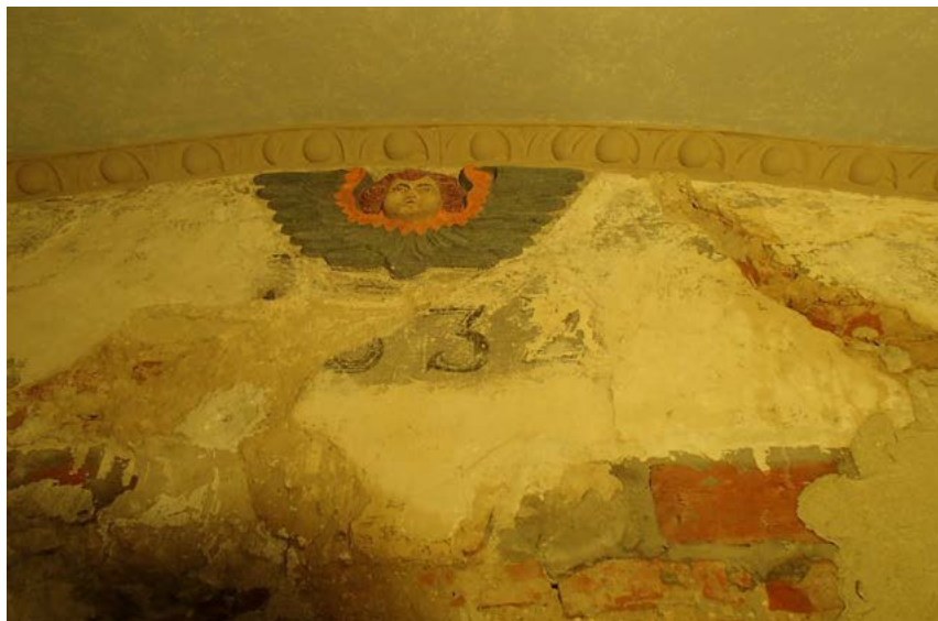
Ryc. 1. Fragment daty na ścianie tęczy odsłonięty w trakcie prac konserwatorskich w 2013 r. fot. K. Janus
