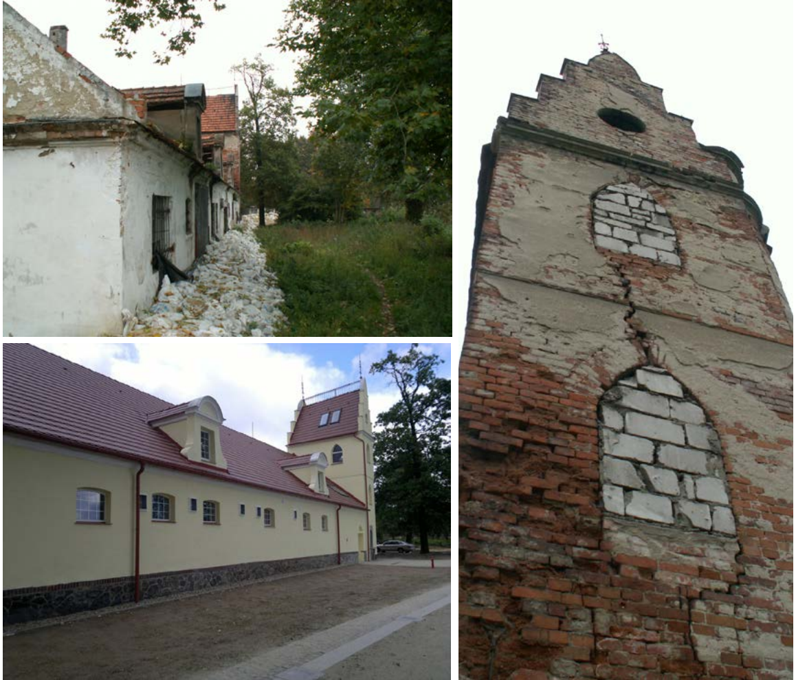
Ryc. 9. Widok obiektu od strony bulwaru wzdłuż koryta Odry sprzed i po realizacji, foto autorki View of the object from the boulevard along the Odra river before and after the works, foto author
