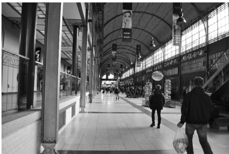
Ryc. 1. Dworzec Wrocław Główny, hol dworcowy, lokalizacja komercyjnych lokali usługowych na tarasach – dawnych peronach; stalowa konstrukcja hali harmonizuje ze neogotyckim stylem architektonicznym budynku; pojedyncze elementy wskazujące na funkcje kulturalne (tu instalacja z książek wskazująca na wypożyczalnię książek na podróż), fot. W. Jabłoński, październik 2016 r.
