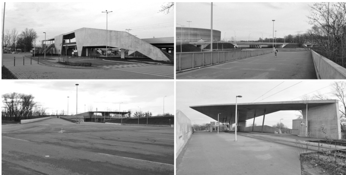
Ryc. 6. Węzeł przesiadkowy Wrocław Stadion, surowa architektura przestrzeni komunikacji; przestrzeń transferowa między przystankiem a stadionem wykorzystywana do rekreacji; dynamiczne zadaszenie o kształcie zbliżonym do trójkąta przykrywające głównie peron w kierunku centrum miasta, fot. W. Jabłoński, grudzień 2016 r.
