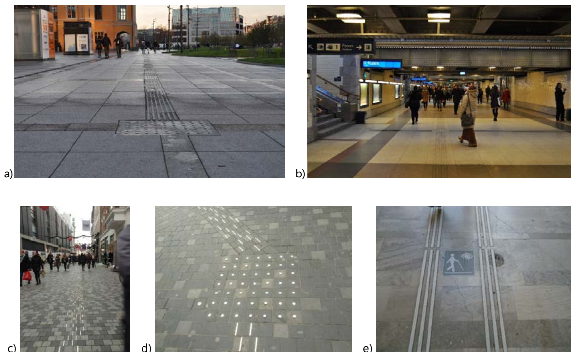
Ryc. 11. Ryc. 11. Ścieżki dotykowe i pola ostrzegawcze; A – Plac dworcowy, Wrocław; B – Dworzec Wrocław Główny, tunel pod peronami; fot. W. Jabłoński; C – Kopenhaga, ścieżka dotykowa w formie pojedynczych pasków w drobnej kostce brukowej, nawiązuje do nawierzchni i nadaje indywidualny charakter ścieżki wpasowujący się w estetykę przestrzeni; D – Kopenhaga, pole ostrzegawcze ścieżki dotykowej na il. 11 C również wpasowujące się w charakter pasów naprowadzających; D – Paryż, ścieżka dotykowa; fot. E. Przesmycka
