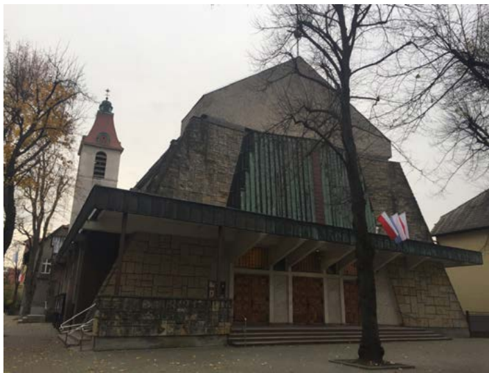
Ryc. 7. Przebudowana elewacja północna.
