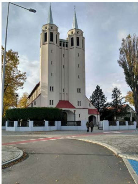
Ryc. 10. Elewacja wschodnia z dwoma wieżami.
