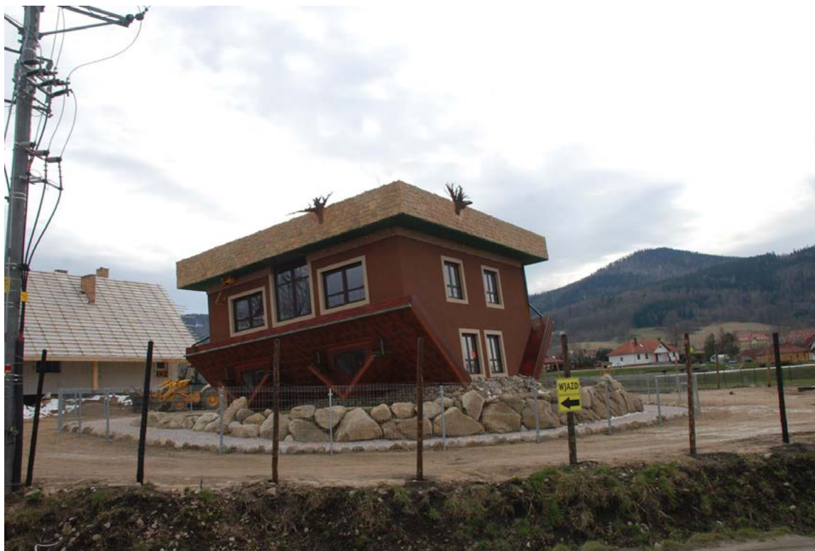
Ryc. 5. Dom na głowie w Miłkowie na końcowym etapie realizacji budowy. (fot. Aleksandra Głównyńska, 2015)
