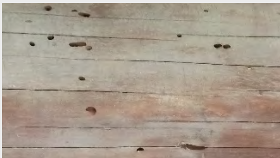
Ryc. 17. Chałupa z Huty Dzierążyńskiej, brak nowych otworów wylotowych może świadczyć o nieaktywnym żerowisku spuszczela pospolitego
