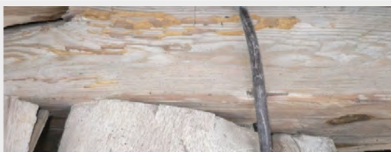
Ryc. 26. Chałupa z Urzędowa, aktywne żerowisko owadów [9]
