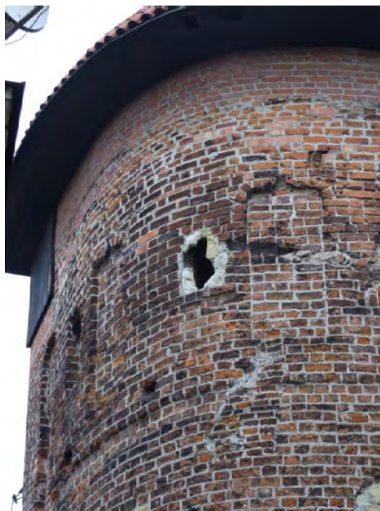
Ryc. 4. Widok elewacji południowej z dekoracją architektoniczną blend, gzymsu wklęsłego oraz kamiennych kluczy strzelnic
