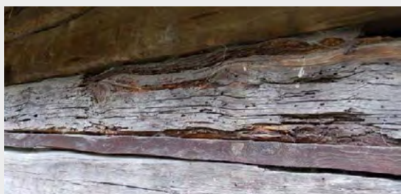
Ryc. 8. Chałupa z Brzezina, intensywne porażenie owadami sumika ściany zewnętrznej [4]
