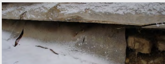
Ryc. 30. Chałupa z Bukowej, izolacja z papy pod belką podwalinową [11]
