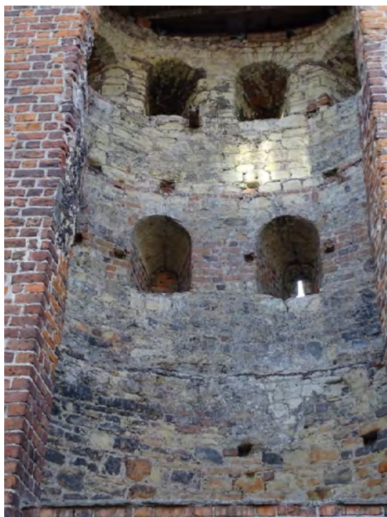
Ryc. 3. Fragment widoku kondygnacji trzeciej z ceglany mianiem w pasie otworów strzelniczych
