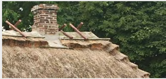
Ryc. 13. Chałupa z Niemiec, komin po pracach remontowych, wymieniona strzecha
