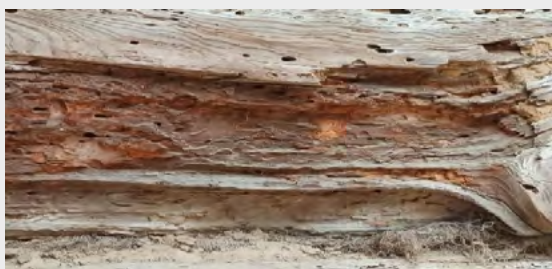
Ryc. 21. Chałupa z Urzędowa, brak nowych otworów wylotowych
