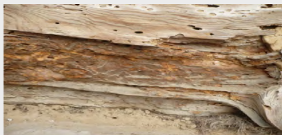
Ryc. 20. Chałupa z Urzędowa, bierne żerowiska owadów [9]
