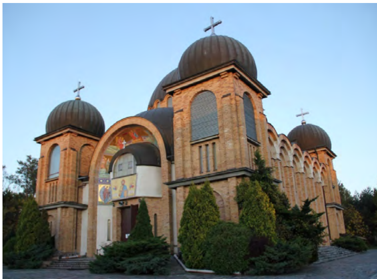
Ryc. 4. Cerkiew pw. Mądrości Bożej – Hagia Sophia w Białymstoku – widok od strony wejścia. Źródło: fotografia autora
