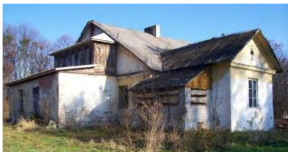
Fot. 3. Dwór w Pilaszkowicach, widok naroża południowo-zachodniego. Stan na 2007 r.
