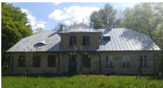
Fot. 23. Elewacja tylna, zachodnia
