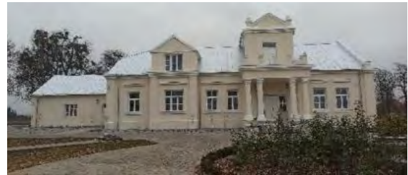
Fot. 20. Dwór w Stawie Noakowskim, widok elewacji południowo-zachodniej. Stan na 11.2021
