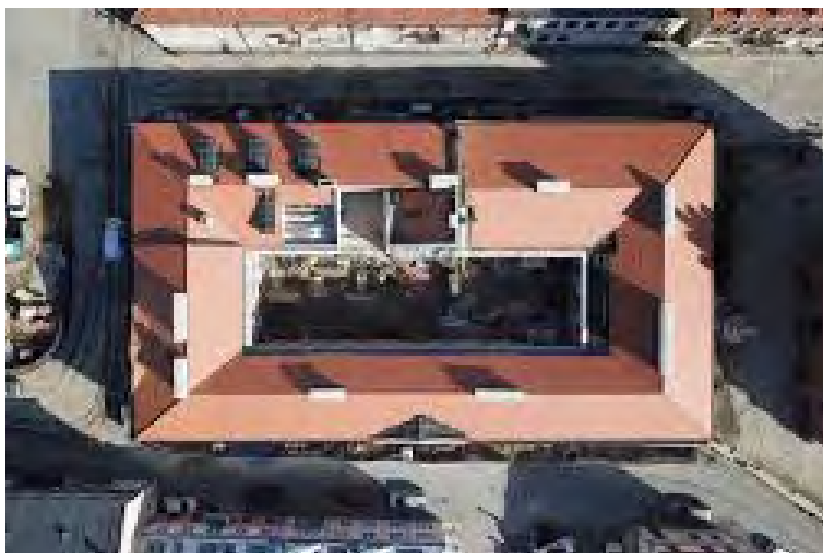
Ryc. 1. Regularny kształt Domu Deskurów z wewnętrznym obudowanym patio w czasie prac remontowych – widok z góry [22]
