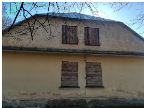
Fot. 22. Elewacja boczna, północna
