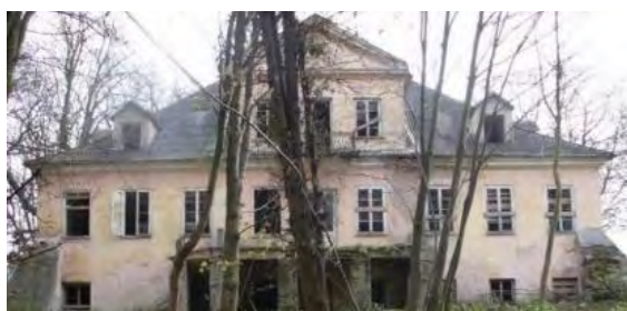
Fot. 11. Dwór w Dąbiu, widok elewacji północnej. Stan na 2007 r.
