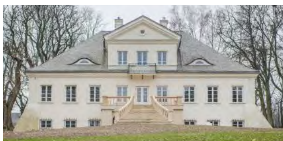
Fot. 12. Dwór w Dąbiu po pracach renowacyjnych, widok elewacji północnej [12]. Stan na 2016 r.
