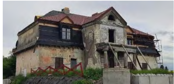
Fot. 18. Dwór w Siedliszczkach, w trakcie prac remontowych, widok elewacji zachodniej. zdjęcie z FB. Stan na 07.2021
