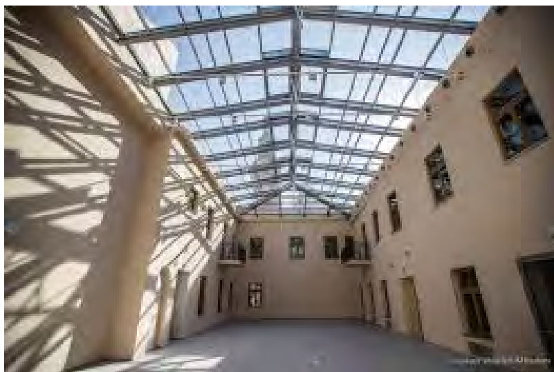
Ryc. 4. Wytworzone patio z przykryciem szklanym dachem – pozwoliło na stworzenie otwartej przestrzeni integracyjnej całego budynku [23]
