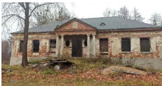
Fot. 7. Dwór w Suchodołach, widok elewacji południowo-zachodniej. Stan na 11.2021
