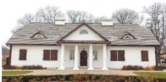
Fot. 14. Dwór w Krasnymstawie po pracach remontowych, widok elewacji południowej. Stan na 11.2021
