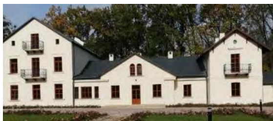
Fot. 16. Dwór w Rybczewicach, po pracach remontowych, widok elewacji południowej. fot. Urząd Gminy Rybczewice. Stan na 2021 r.
