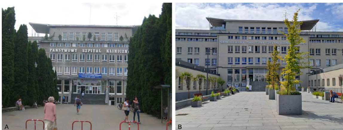
Ryc. 3. Jeden z badanych budynków szpitali – Samodzielny Publiczny Szpital Kliniczny nr 4 w Lublinie. A – widok głównego budynku przed modernizacją. Fot. G. Dyś, 2013; B – widok budynku po termomodernizacji. Fot. R. Strojny, 2023
