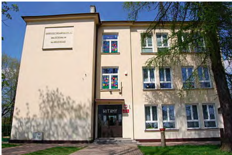
Ryc. 8. Budynek szkoły powszechnej w Motyczu, stan obecny, https://www.motycz.eu/szkola-motycz/bystrzejowice , 23.06.2022
