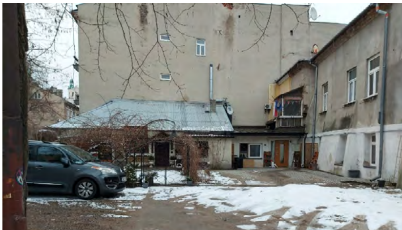
Ryc. 5. Obiekt zakwalifikowany do rozbiórki oraz przykład przestrzeni wymagającej uzupełnienia zabudową plombową. Źródło: Autorzy
