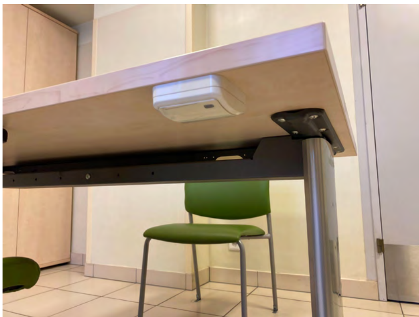
Ryc. 7. Przycisk alarmowy pod stołem lekarskim. Źródło: Daria Smyl
