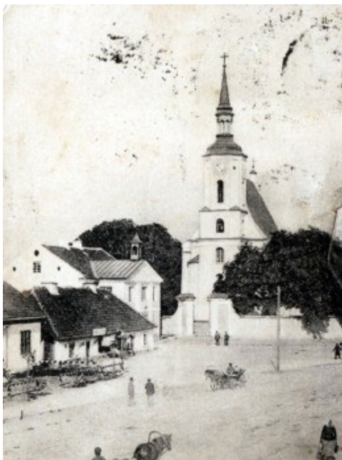
Ryc. 1. Kościół pw. Wniebowzięcia Marii Panny (1617–1626)
