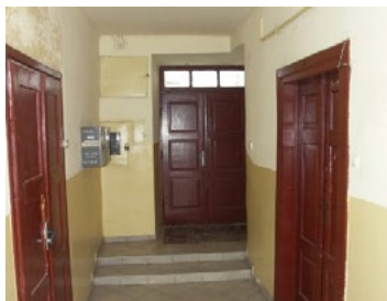
Ryc. 14. Parter, sień – widok na podcięty otwór wejścia głównego. Fot. K. Janus Fig. 14. Ground floor, hall – view on cut opening main entry. Photo K. Janus
