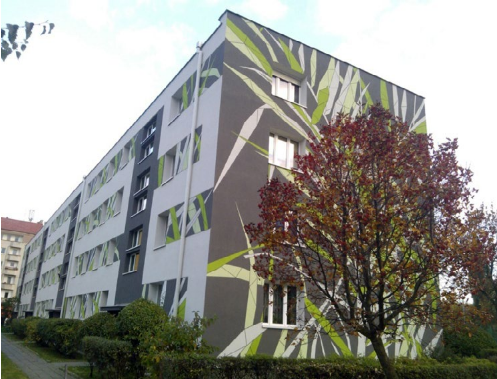
Ryc. 4. „Pospolite ruszenie” – modernizacja elewacji. Źródło ilustracji: własne archiwum Fig. 4. Social campaign “Pospolite ruszenie” – modernization of the facade. Source: M. Dmitruk
