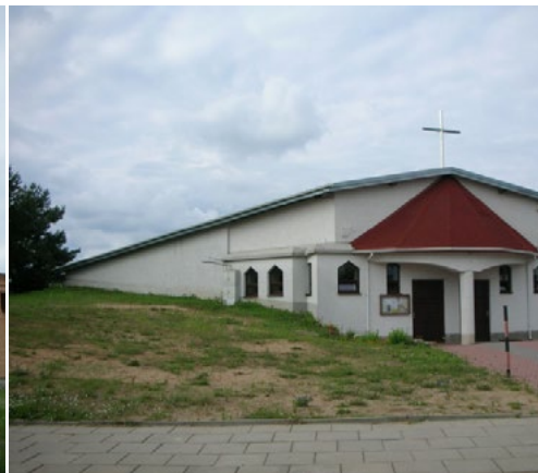
Ryc. 16. Kościół pw. NMP Nieustającej Pomocy, arch. Andrzej Nowakowski, proj. 2000.
