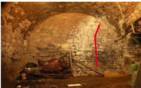
Ryc. 12. Piwnica, część C, widok na ścianę wschodnią z zaznaczeniem zamurowanego otworu. Fot. K. Janus Fig. 12. Basement, part C, the view on eastern wall with mark of the wall up opening. Photo K. Janus
