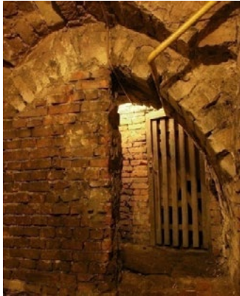
Ryc. 8. Piwnica, część F, przejście do części E. Fot. K. Janus Fig. 8. Basement, part F, passage to part E. Photo K. Janus
