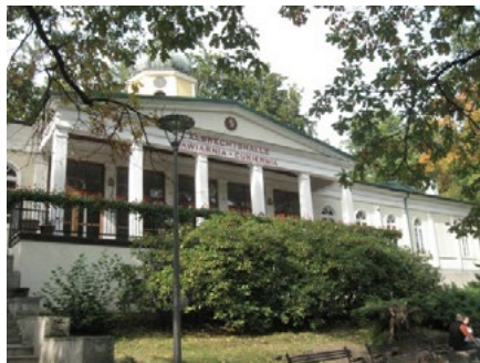
Rys. 4. Dawna hala spacerowa w Łądku Zdroju, (fot. M. Piróg)
