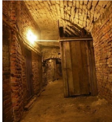
Ryc. 9. Piwnica, część F, widok na ścianę wschodnią. Fot. K. Janus Fig. 9. Basement, part F, view on eastern wall. Photo K. Janus
