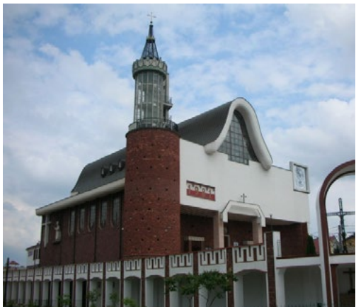
Ryc. 1. Kościół pw. Św. Kazimierza Królewicza, arch. Jan Krutul (1983–1993)
