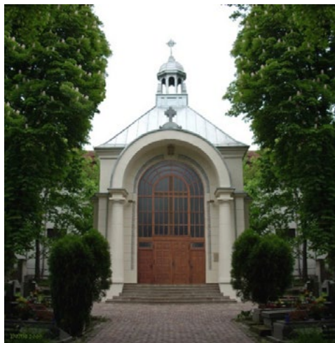
Ryc. 2. Kaplica cmentarna po pracach remontowych przeprowadzonych w roku 2007 – fot. ze zbiorów WKZ w Lublinie Fig 2. The cemetery chapel after restoration works in 2007, source: WKZ Lublin
