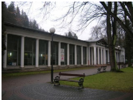
Ryc. 3. Hala spacerowa w Dusznikach-Zdroju, (fot. M. Piróg)
