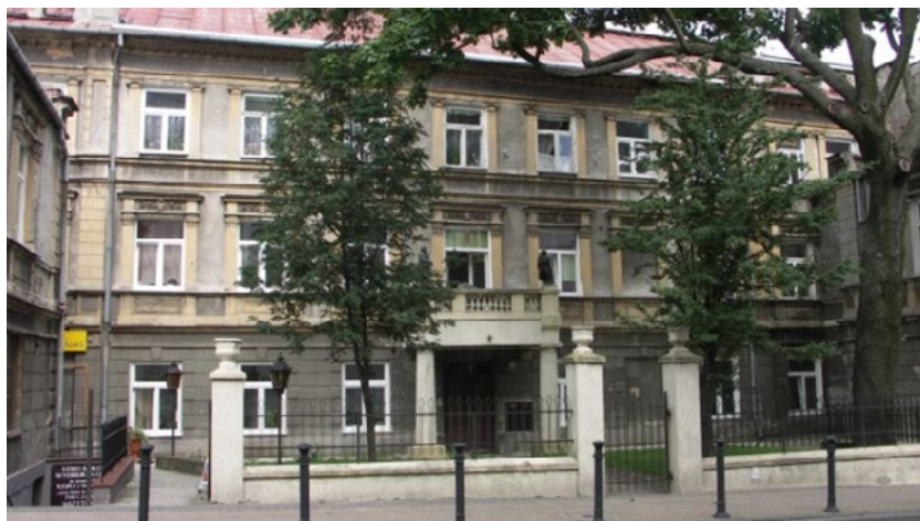
Ryc. 16. Elewacja frontowa. Fot. K. Janus Fig. 16. Front facade. Photo K. Janus
