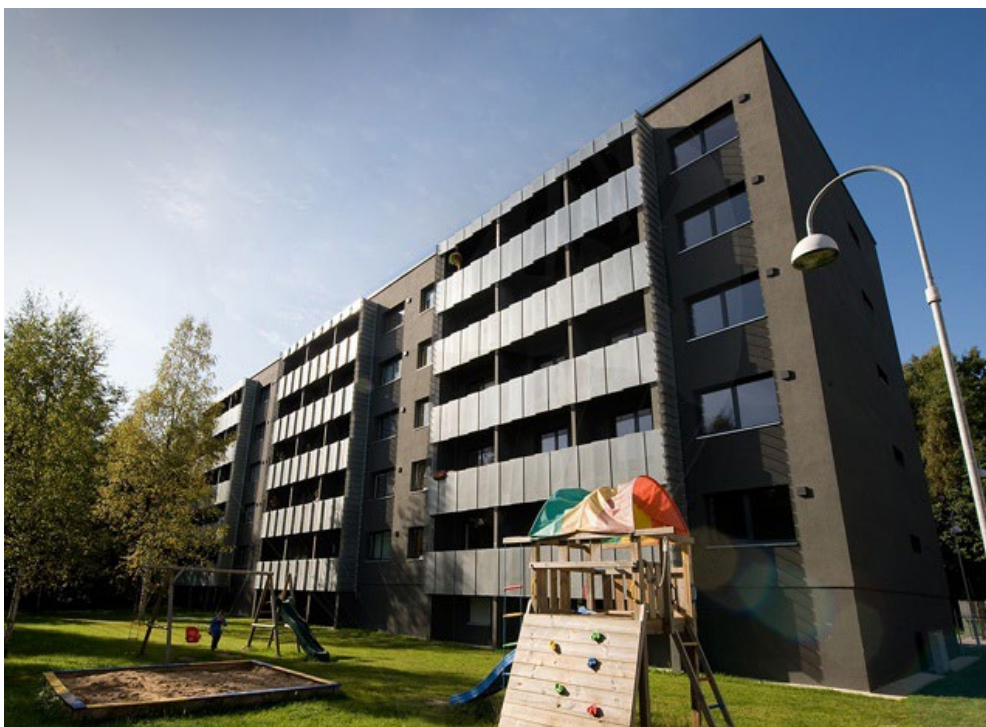
Ryc. 5. Modernizacja budynku z wielkiej płyty, Haapsalu, Estonia. Źródło ilustracji: http://www.professionals.ee Fig. 5. Modernisation of the “great panel” building in Haapsalu, Estonia. Source: http://www.professionals.ee
