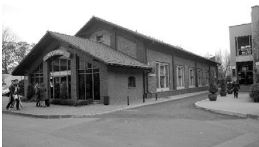
Ryc. 1. Politechnika Krakowska – Kotłownia.
