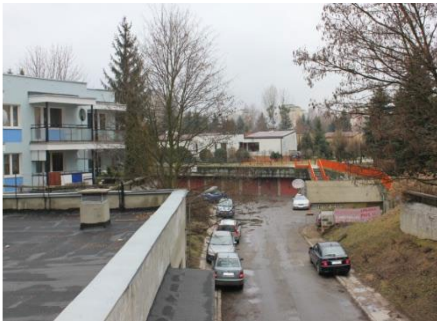
Ryc. 6. Wbudowane w skarpe garaże. Widok z kładki nad drogą dojazdową. Autor fotografii: Michał Dmitruk
