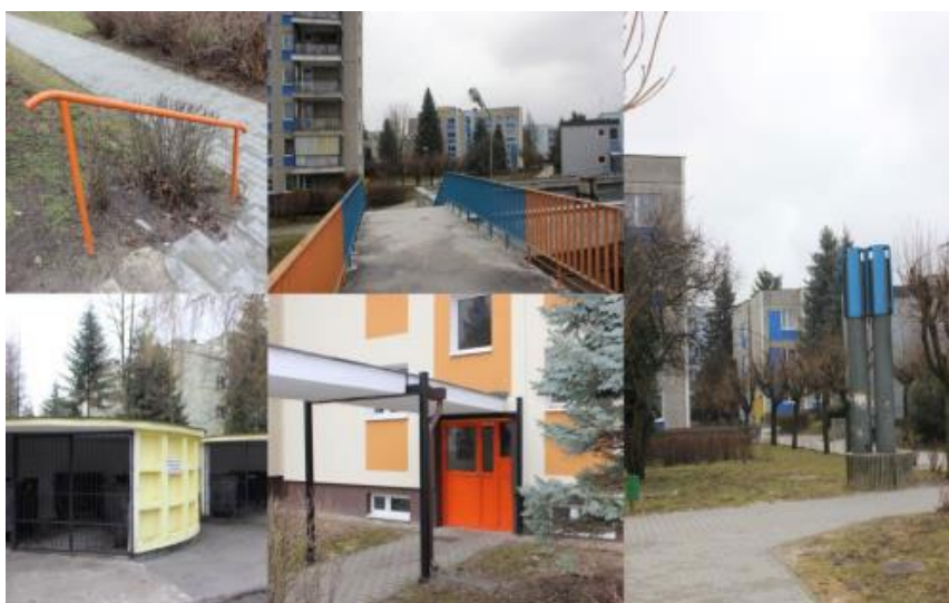
Ryc. 14. Kolorowe elementy wykończenia i małej architektury. Autor fotografii: Michał Dmitruk
