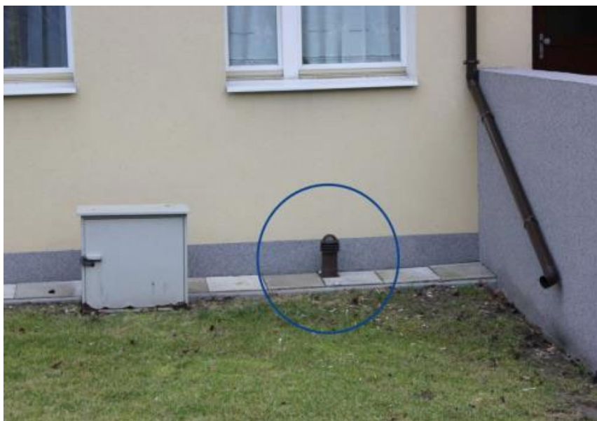
Ryc. 17. Jedno z urządzeń wspomagających cyrkulację powietrza wewnątrz budynku. Autor fotografii: Michał Dmitruk
