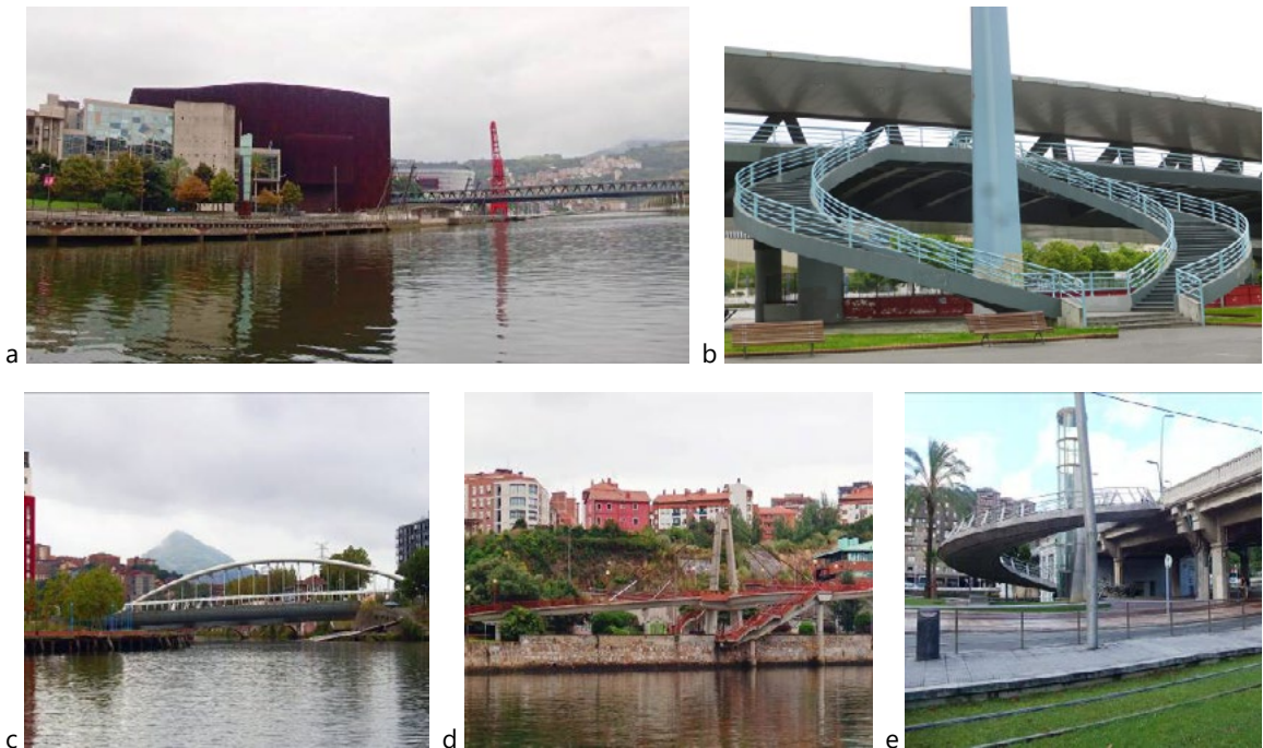
Ryc. 12. a-b) Euskalduna Zubia c) hybridowy most stalowy o jednym łuku, Altos Hornos d) żelbetowy most podwieszony nad ul. Madaripe Bidea e) Deustuko Zubia , wejście na most a-b) Euskalduna Zubia c) hybrid steel bridge with one arch, Altos Hornos d) RC suspension bridge over Madaripe Bidea str. e) Deustuko Zubia , entering the bridge
