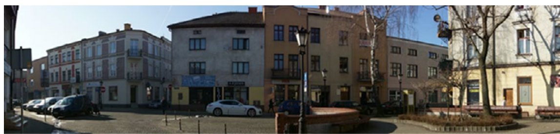
Ryc. 2. Oświęcim. Odnowiona kamienica narożna przy ulicy Klasztornej oraz Mały Rynek
