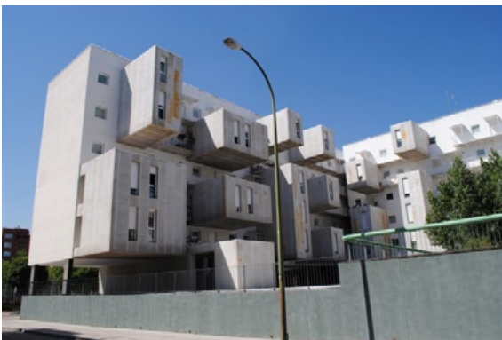
Ryc. 11. Wsporniki na elewacjach 102 social dwellings in Carabanchel (2008, arch. Ignacio Borrego, Néstor Montenegro and Lina Toro – Dosmasuno Arquitectos).
