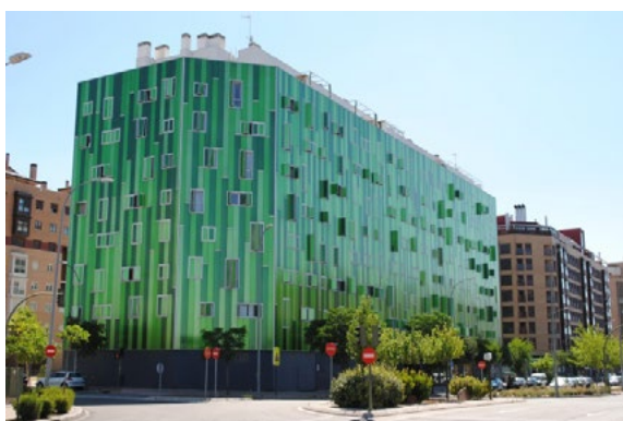
Ryc. 7. Pierzejowa zabudowa Edificio Vallecas 51 (2006–09, arch. Luis Burriel Bielza, Pablo Fernandez Lewicki, Jose Antonio Tallon Iglesias – SOMOS Arquitectos).
