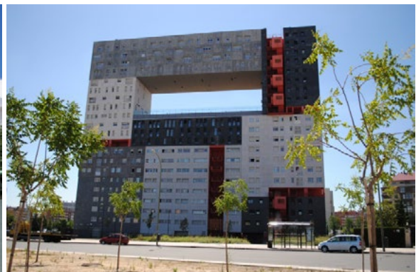
Ryc. 12. Edificio Mirador w Las Tablas – budynek o skomplikowanej (mostowej) konstrukcji przewieszona (2005, arch. MVRDV).
