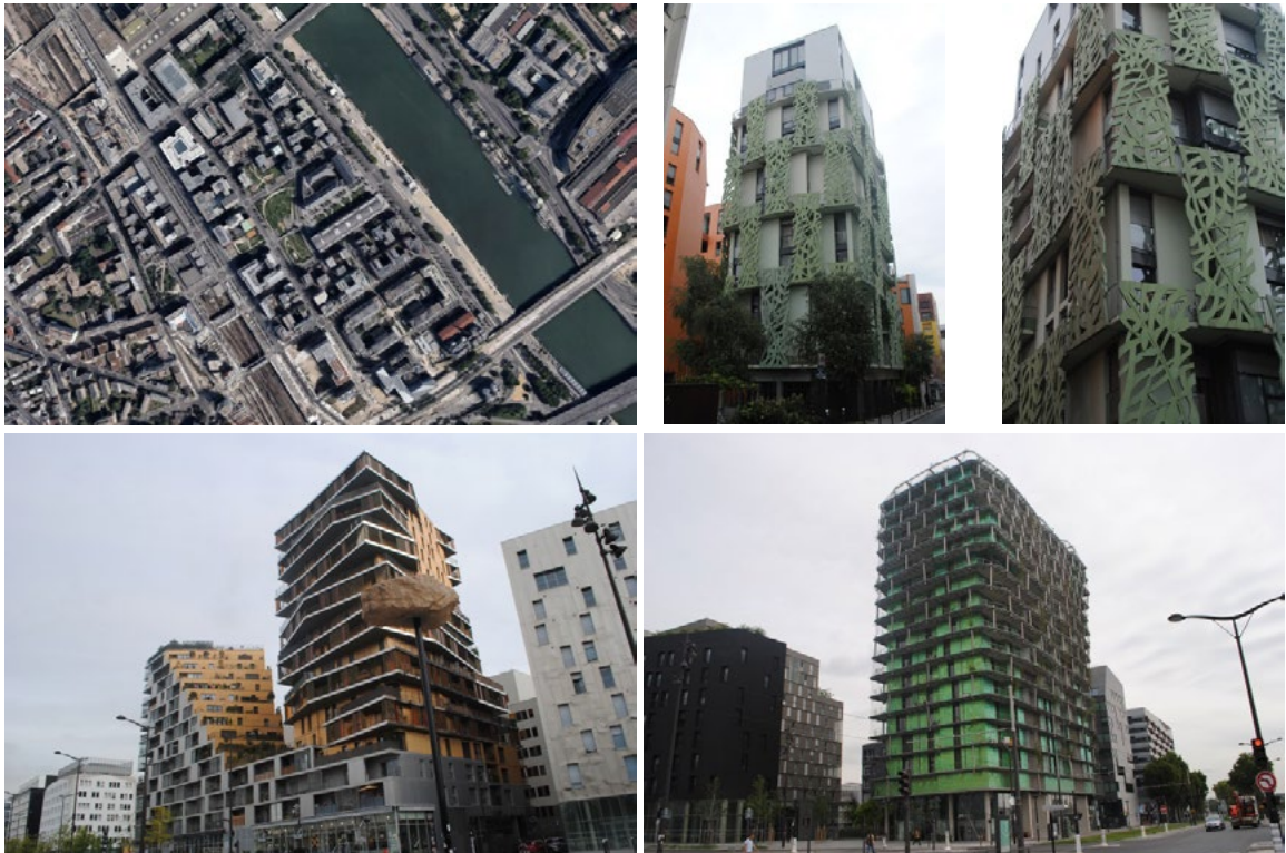
Ryc. 16. Francja, Paryż, XIII dzielnica, zabudowa mieszkaniowa wokół parku Moulines Abbé. A) Fotografia lotnicza. B,C) Budynek mieszkalny przy 18 Rue Hélène Brion (2007). D) Bâtiment Home (2012–15, arch. Hamonic + Masson & Associés). E) M6B2 Tower of Biodiversity (2016, arch. Edouard Francois).
