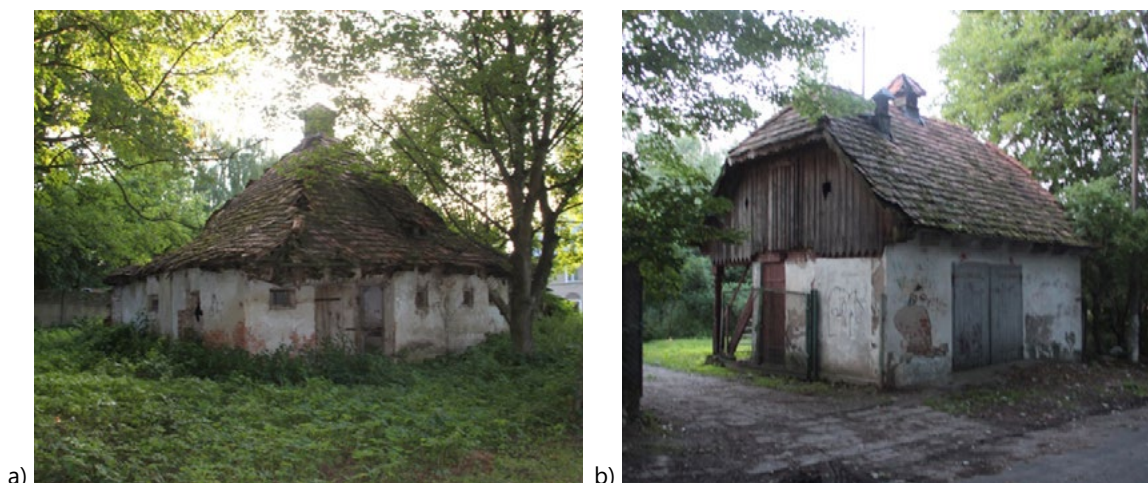
Ryc. 12. Budynki gospodarcze w Wożuczynie-Cukrowni, stan obecny, fot. K. Boguszewska, lipiec 2017
