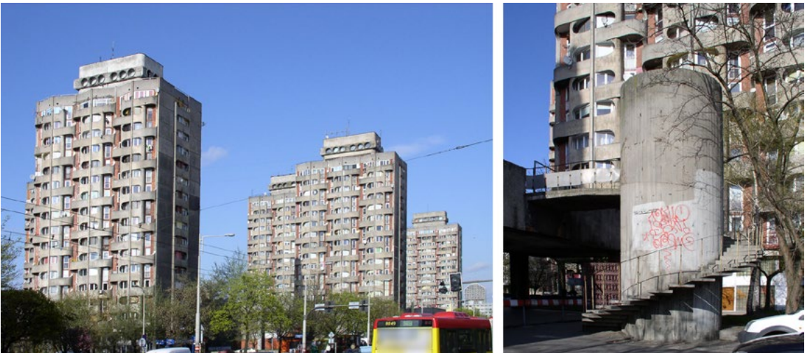
Fig. 2. Modernism in Wrocław, Poland, housing estate by designed by Jadwiga Grabowska-Hawrylak – humanization of buildings in high prefabricated buildings – technical condition from before renovation (beginning in 2015). [Own photographs] Modernizm we Wrocławiu, Polska, osiedle wg. proj. Jadwigi Grabowskiej-Hawrylak – humanizacja zabudowy w wysokich obiektach prefabrykowanych – stan techniczny z przed remontu (początek w 2015 r.). [Fot. autorzy]
