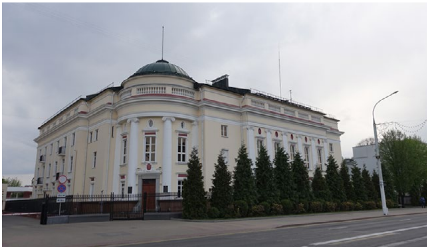
Fig. 6. Brześć nad Bugiem (Białoruś) The building of Polish Bank, photo. K. Paprzyca, 2018
