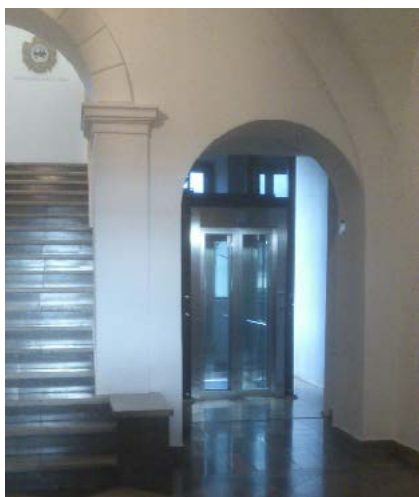
Fig. 5. The lift installed in the Zamość Town Hall, Zamość. Photo: Katarzyna Kielin
