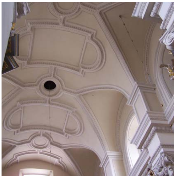
Ryc. 1. Rzeszów, nawa główna kościoła Bernardynek (później Pijarów). Widok na sklepienie nawy głównej
