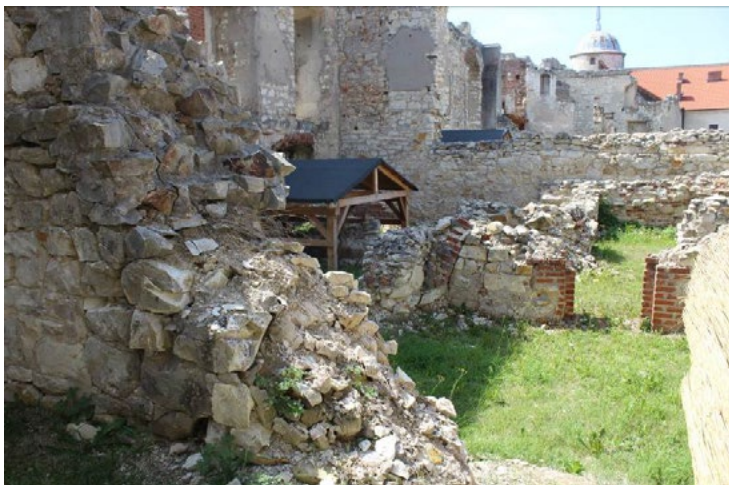
Ryc. 17. Mury dawnego pałacu przy amfiladzie południowej. Autor: Katarzyna Drobek
