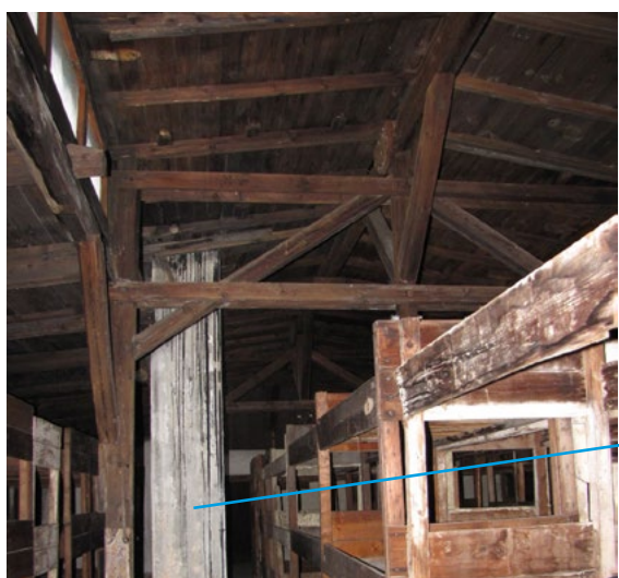
Ryc. 3. Barak nr 15. Komin wewnątrz baraku
