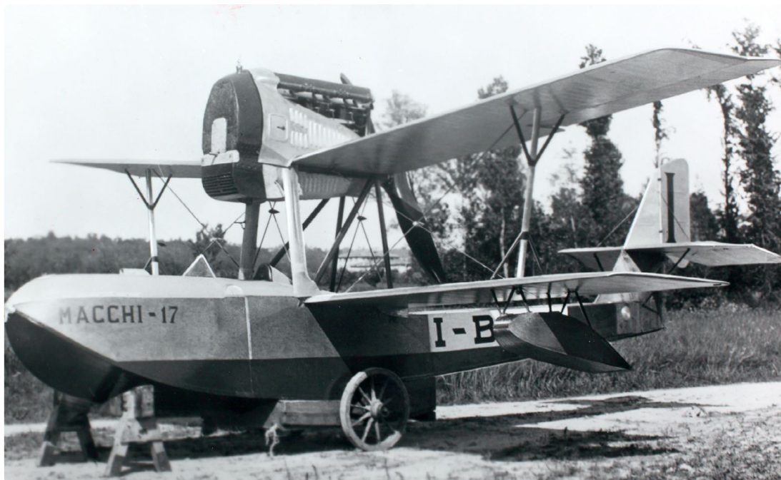
Ryc. 16. Samolot M.17 (nr rejestracyjny I-BAHG) przygotowany na zawody w Neapolu. Zwracają uwagę pojedyncze zastrzały skrzydłowe wzmacniane mieczami
