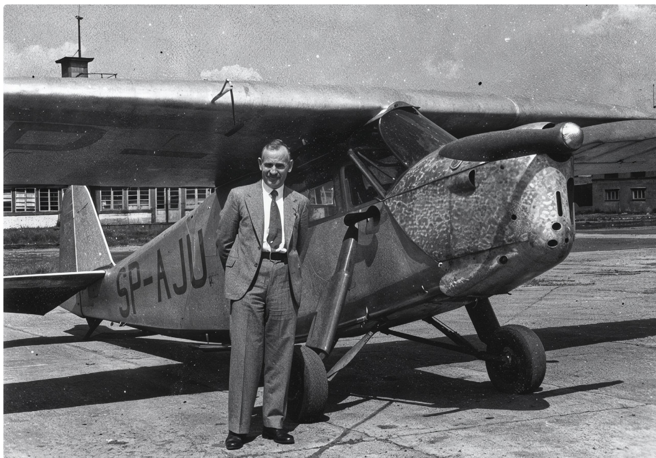
Ryc. 2. Stanisław Skarżyński przy RWD-5 bis. Skrzydła tego samolotu posiadały konstrukcję drewnianą, częściowo kryte były płótnem
