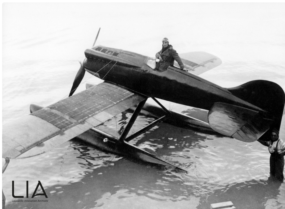
Ryc. 4. Wodnosamolot Macchi M.39. Bardzo dobrze widoczny system chłodzenia cieczy w postaci rurek mosiężnych na górnej powierzchni płata. Zwracają uwagę stosunkowo długie lotki sięgające blisko połowy długości krawędzi spływu
