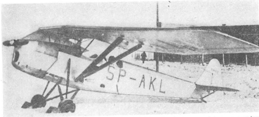
SP-AKL, prototyp dla wojska z silnikiem Walter Junior, z płatem o zwężonych końcach i z prototypowym sterem kierunku
