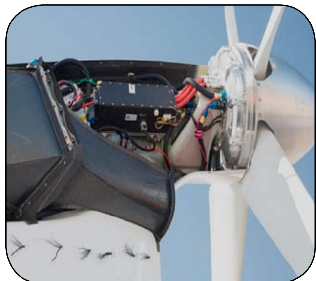
Rys. 3. Silnik napędowy – generator w gondoli
