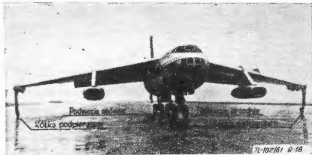
Rys. 18 — Podwozie samolotowe układu rowerowego
