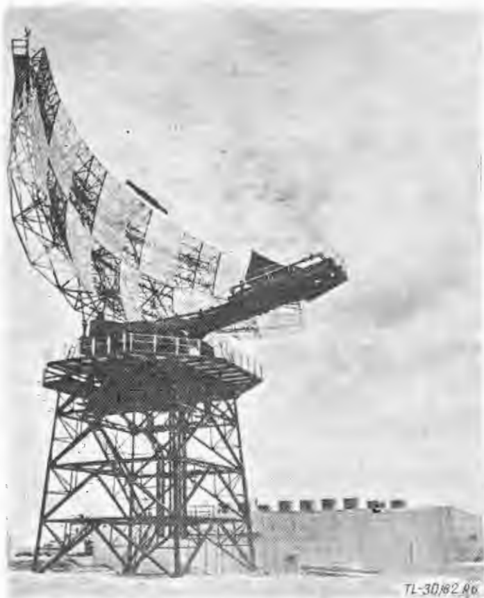
Rys. 6. Radar ostrzegawczy typu AN/FPS-24
