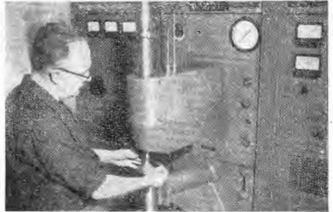
Rys. 9. Ogólny widok amerykańskiej zgrzewarki ultradźwiękowej typu Sonoweld W-2000-SR-57-3
