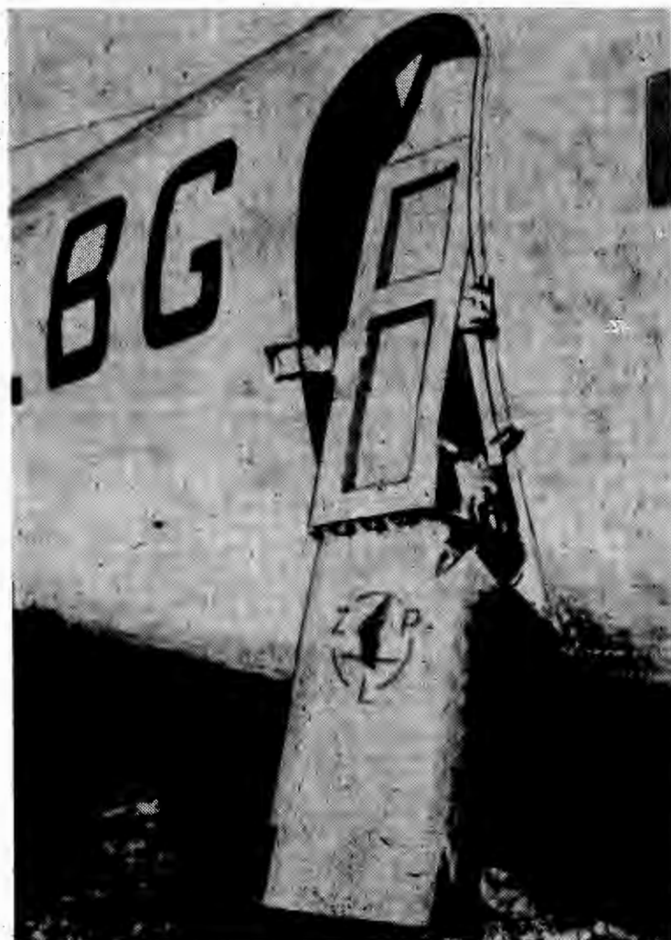
Rys. 3. Rura wylotowa aparatury CSS
